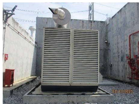
ภาพที่ 2-34 ระบบไฟฟ้าสำรอง
