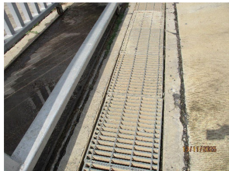
ภาพที่ 2-29 รางระบายน้ำฝนในพื้นที่โครงการฯ
