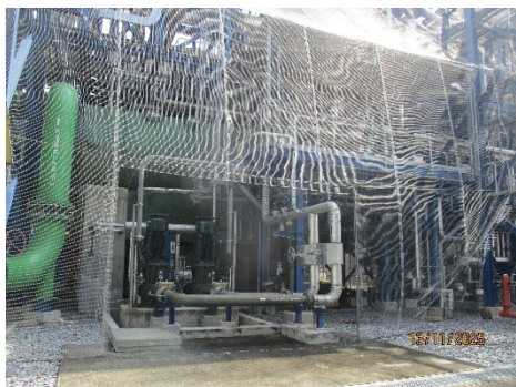
ภาพที่ 2-14 เครื่องควบแน่น (Condenser)
