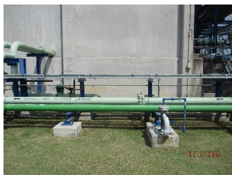
ภาพที่ 2-13 ระบบการเติมอากาศแบบหมุนเวียนน้ำ ในบ่อพักน้ำหล่อเย็น
